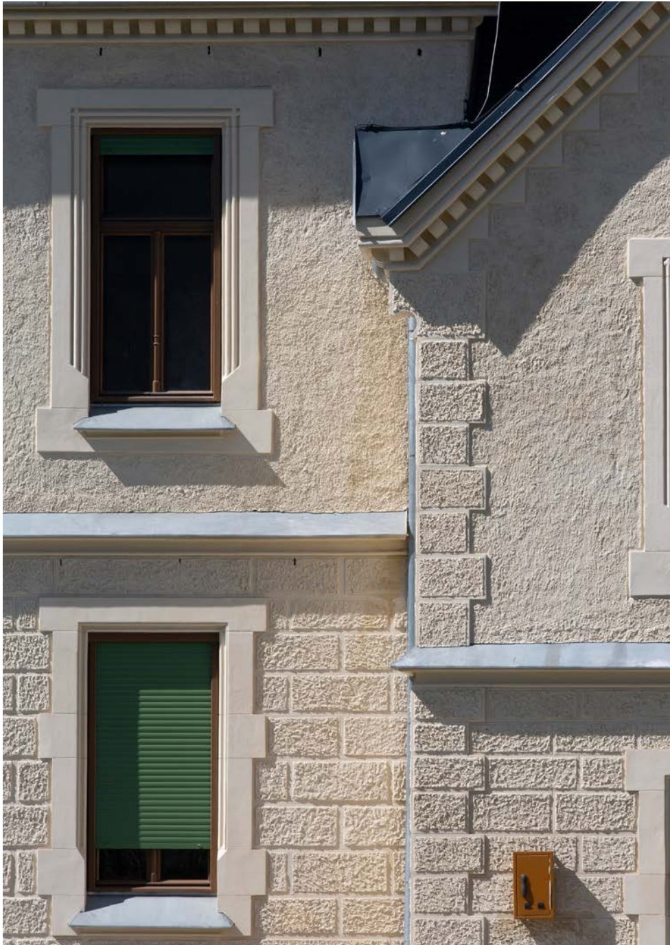
Integration historischer Verschattungssysteme als Teil thermischer Konzepte am Baudenkmal; Objekt: Alter Pfarrhof, Leoben, Steiermark © Bundesdenkmalamt, Foto: Bettina Neubauer-Pregl
