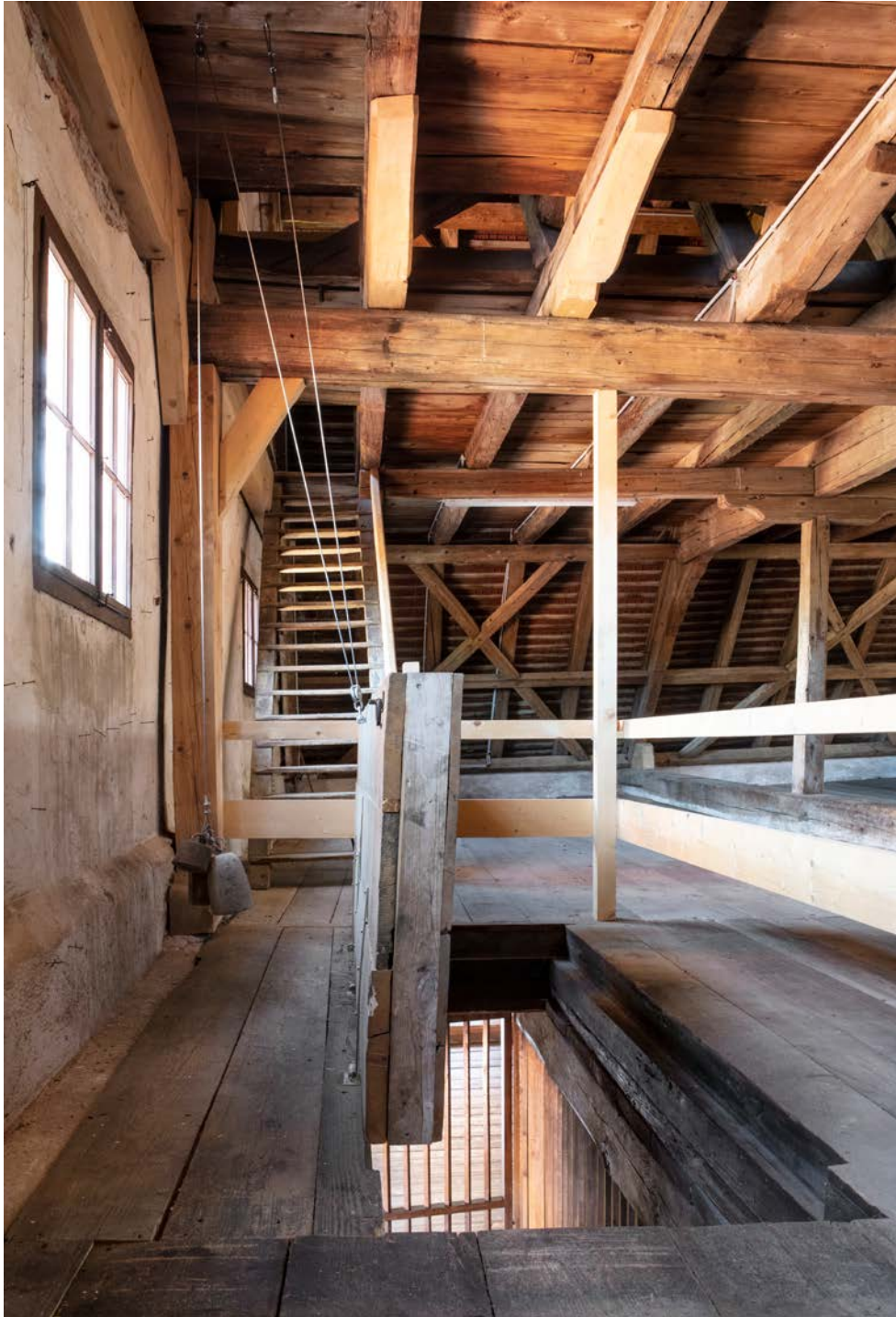
Grenze zwischen temperierten und nicht temperierten Bereichen innerhalb einer Gebäudestruktur; Objekt: Innerberger Stadel, Steyr, Oberösterreich © Bundesdenkmalamt, Foto: Irene Hofer
