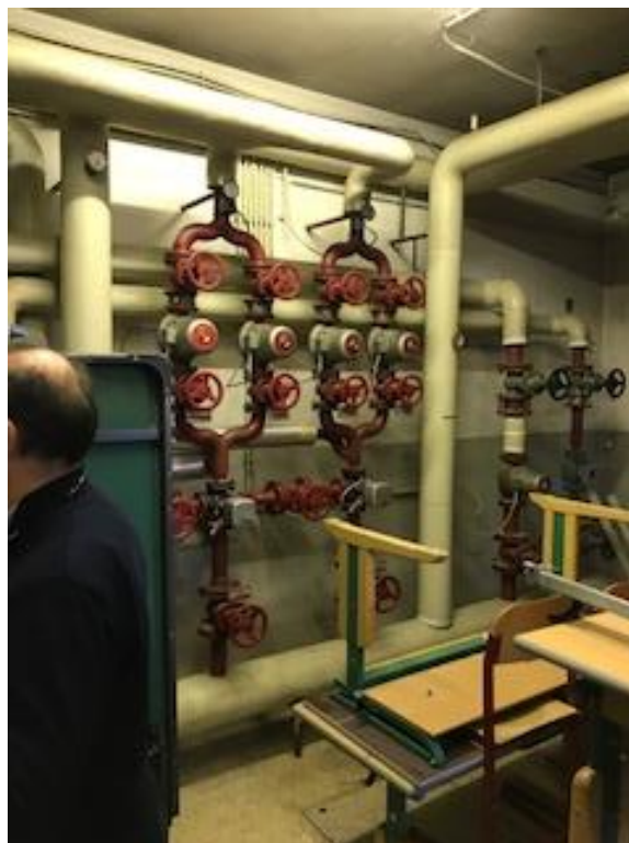
Abbildung 4.2 Heizungsverteiler Schulgebäude
