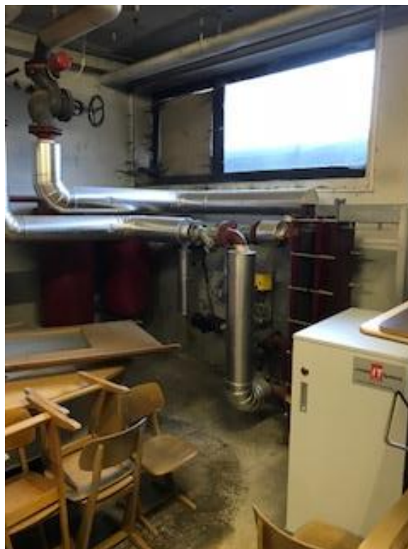
Abbildung 4.1 Fernwärmeübergabestation Schulgebäude
