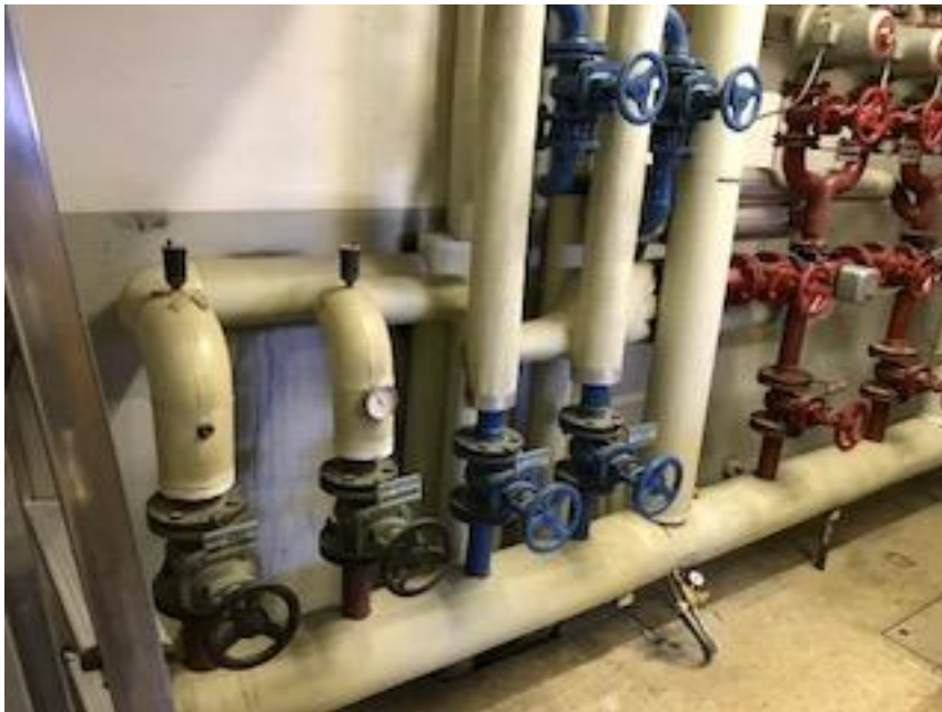
Abbildung 4.3 Heizungsverteiler Schulgebäude
