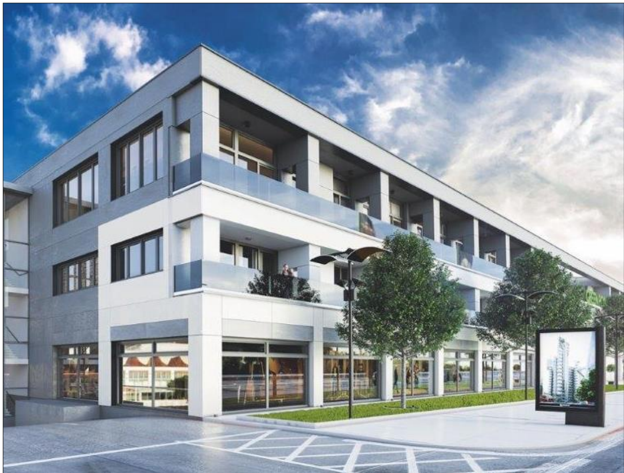
Das Bettenreiter Fachmarkzentrum nach der Sanierung
