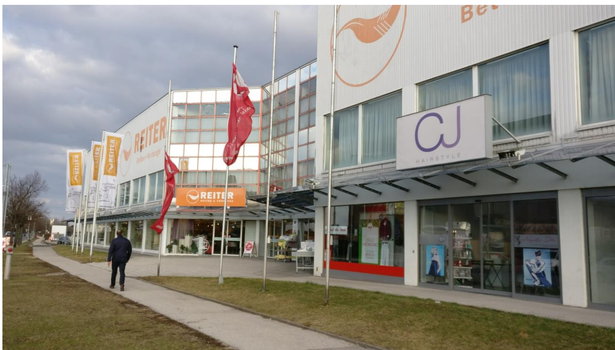
Das Bettenreiter Fachmarktzentrum mit NKD und RENO als Mieter, vor der Sanierung
