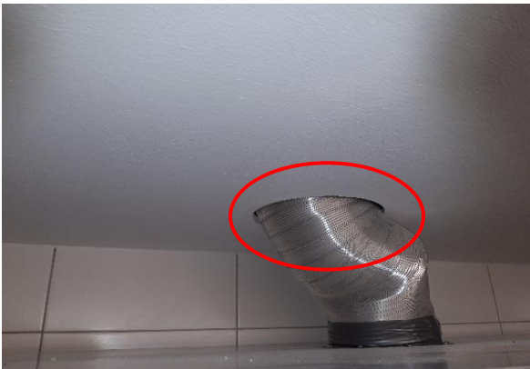
Bild 05 Undichtheit über Fugen der abgesenkten Decke
