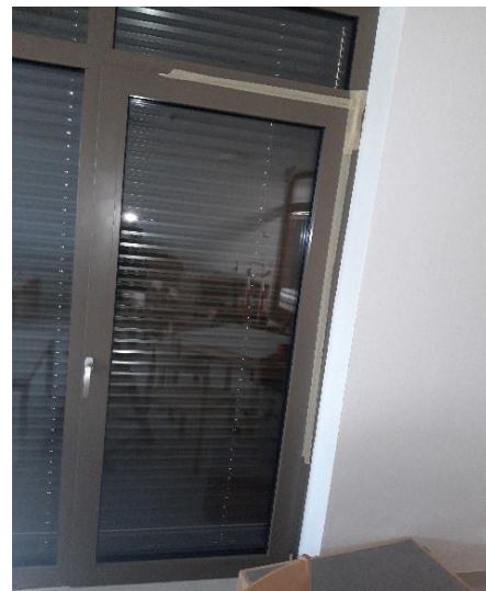
Bild 08 Undichtheit über nicht eingestellten Türflügel
