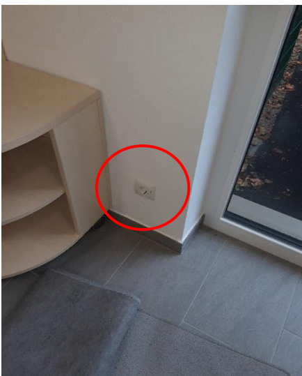
Bild 07 Undichtheit über Fugen E-Installation
