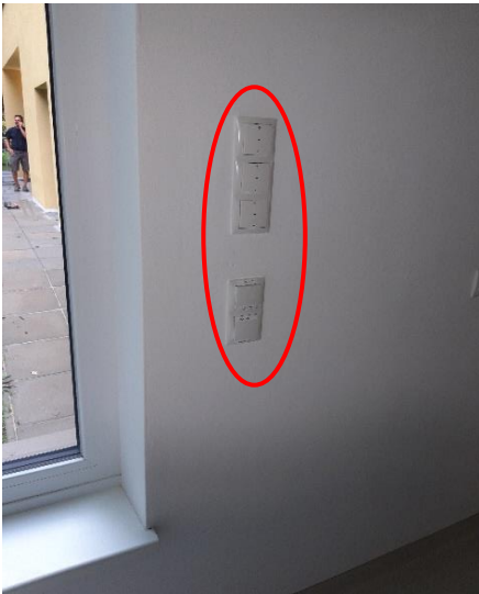
Bild 09 Undichtheit über Fugen E-Installation
