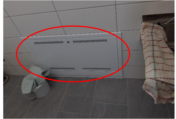
Bild 06 Undichtheit über Fuge heiz-Verteiler
