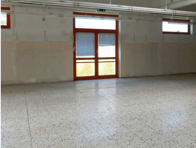
Abbildung 3: erdberührter Fußboden mit Kunststeinbelag
