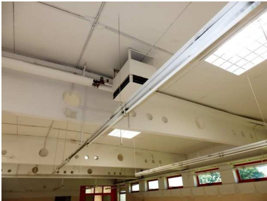
Abbildung 9: Lichtbänder mit Leuchtstofflampen
