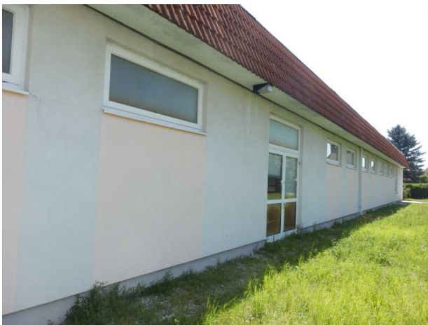
Abbildung 4: Ansicht Fassade Südwest
