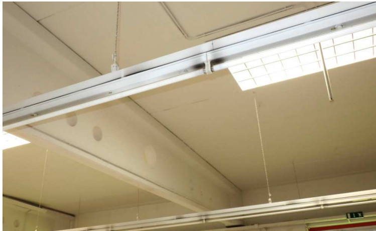
Abbildung 5: Dach mit Lichtkuppel
