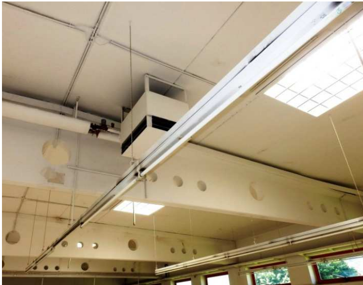
Abbildung 13: Bestandsbeleuchtung mit T8 Leuchtstofflampen
