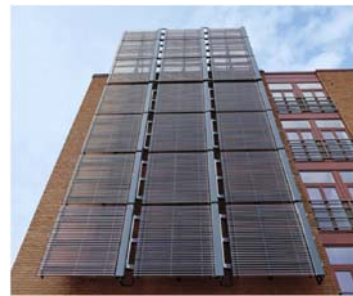
therm. Solaranlage, 80m 2 VAKUUMRÖHREN für WW und Spitzenlast im Winter z.B. an d. Fassade (Anfassbar, ...)
